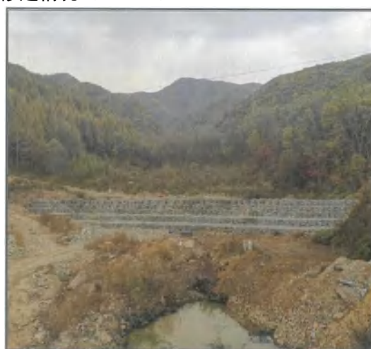
桶子沟弃渣场拦挡坝修建情况（2019.10）
