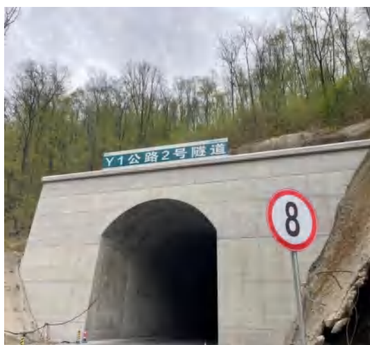
2#隧洞植被恢复情况
