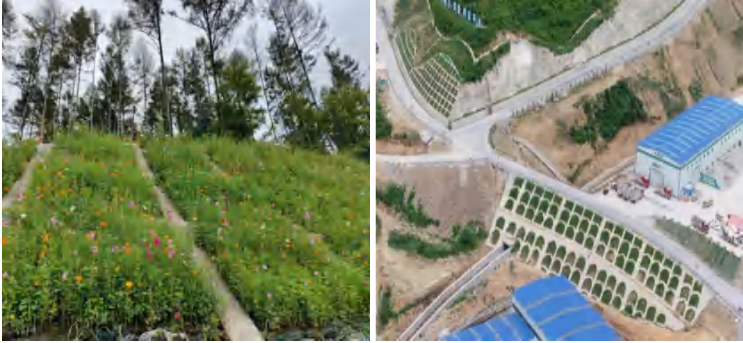
边坡防护及绿化措施
