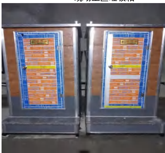
洞室临时旱厕
