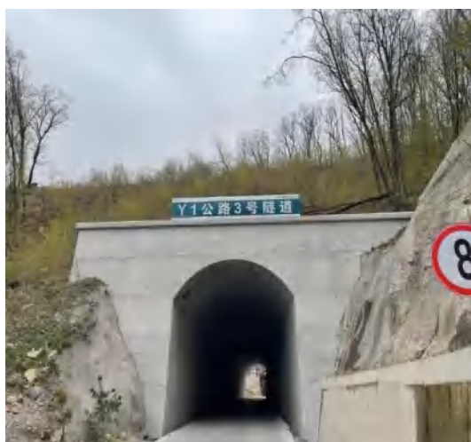
3#隧洞植被恢复情况
