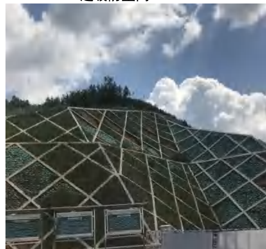
边坡网格绿化措施
