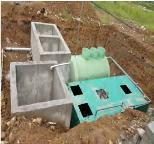
移民安置点污水处理设施（施工期拍摄）
