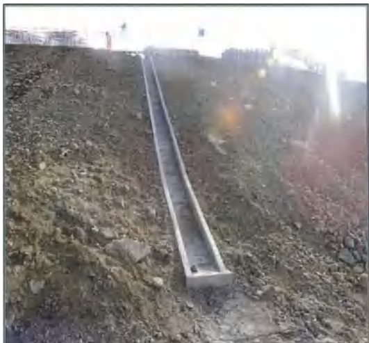
下水库施工场区边坡排水沟建设情况（2017. 10） 业主营地进场路及排水沟修建情况（2019. 7）
