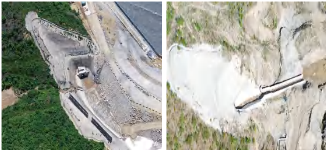
上库导流洞进出口
