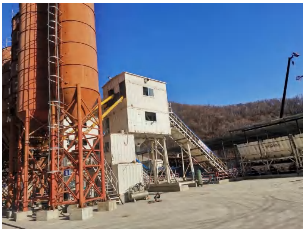
下水库工程混凝土生产系统
