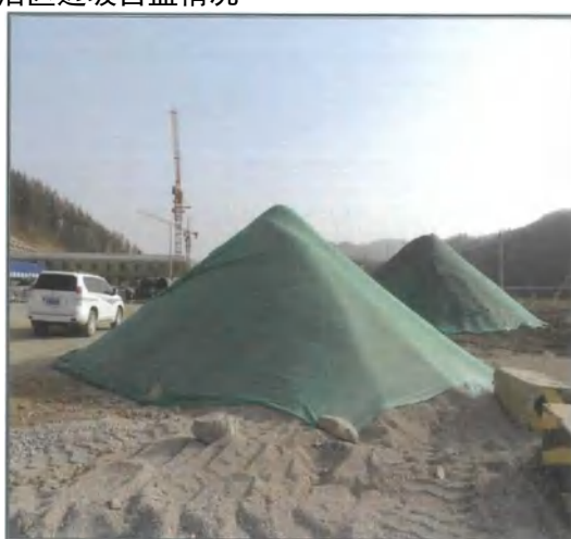
下水库施工场地边坡苫盖防护情况
