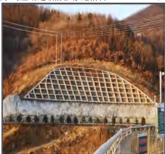
下水库施工场地边坡防护情况（2021. 3）
