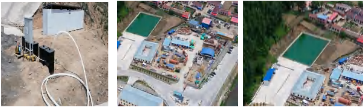
上水库一体化生活污水处理设施 下水库生活污水处理系统位置 清水回用
