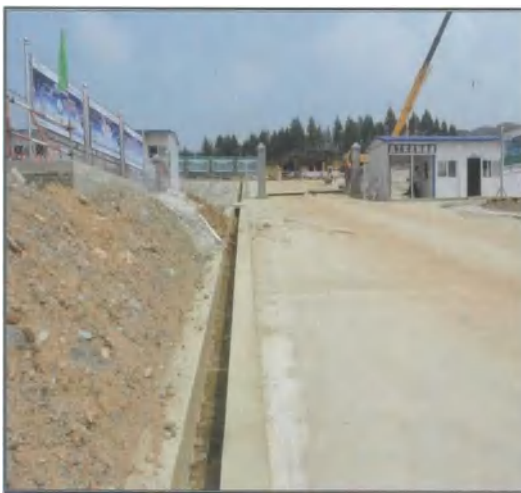
下水库施工场区边坡排水沟建设情况（2017. 10） 业主营地进场路及排水沟修建情况（2019. 7）
