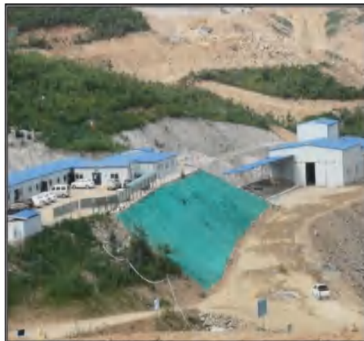
上水库边坡苫盖防护情
