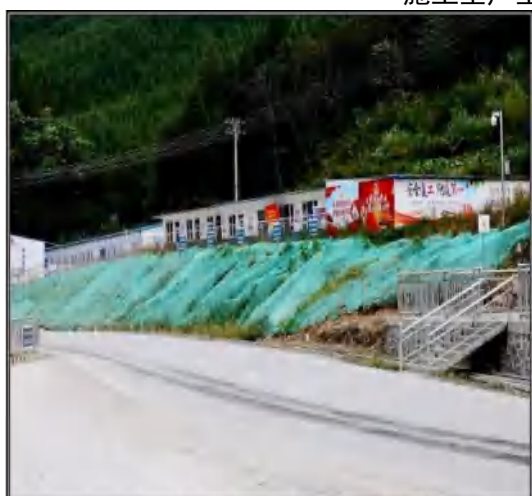
下水库施工场地边坡苫盖防护情况
