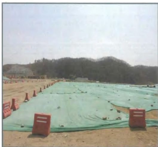
进厂交通洞施工场地苫盖情况
