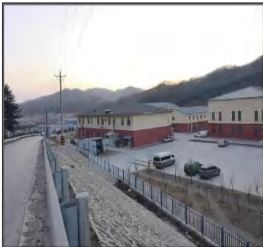
Y1公路路基边坡防护修建情况（2020.12）
