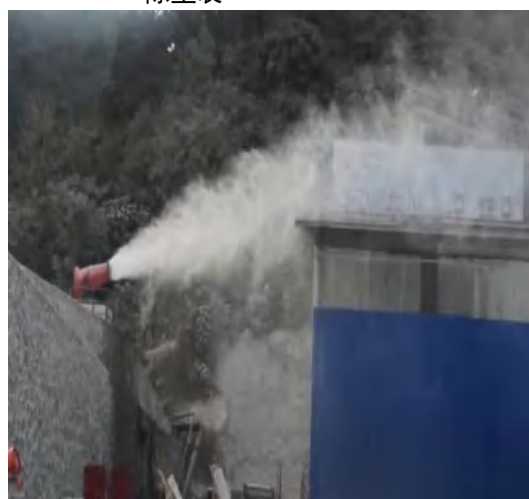
砂石系统喷淋喷雾设施
