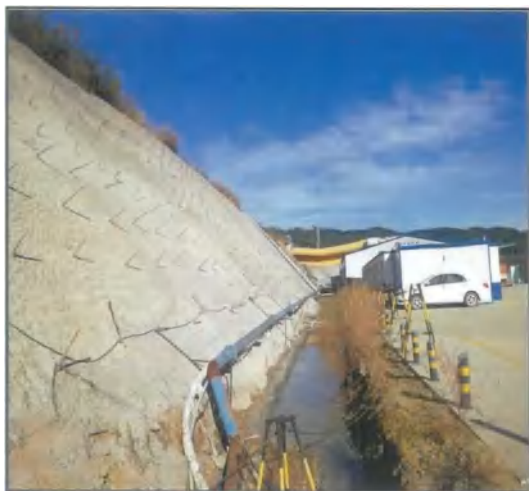
进场交通洞边坡防护及排水沟修建情况 (2019. 9) 进场交通洞边坡防护修建情况 (2019. 10)
