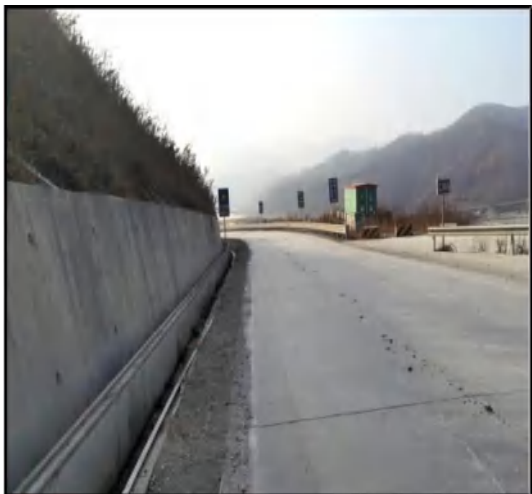
Y1公路排水沟及挡墙修建情况（2021.11）
