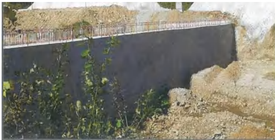
桶子沟弃渣场挡水坝修建情况（2019.9）
