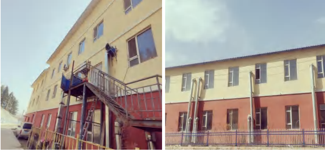
食堂油烟排气筒
