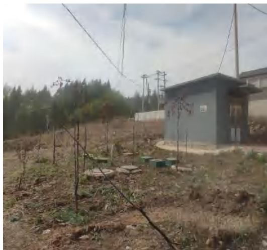
移民安置点生活污水处理设施（建成后）
