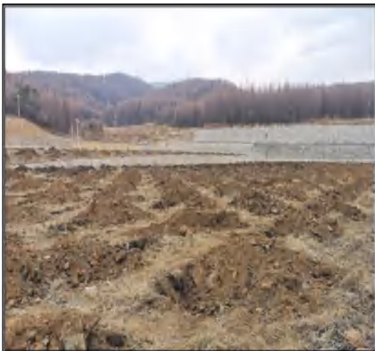
移民安置区整地情况（2020.4）
