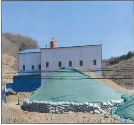
下水库施工区临时堆土拦挡及苫盖情况
