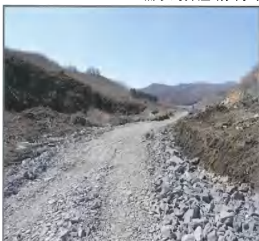
桶子沟弃渣场进场路修建情况（2018.3）
