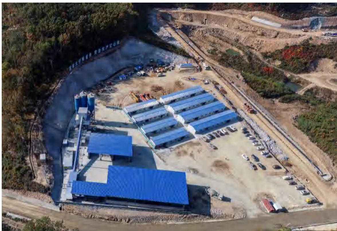
上水库混凝土生产系统
