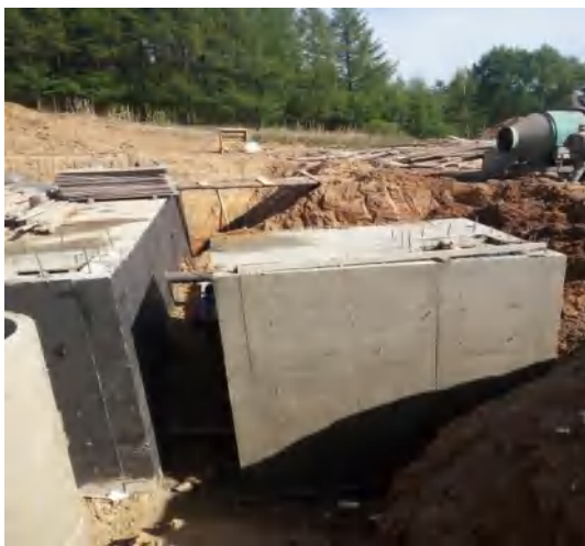
移民安置点生活污水处理设施（施工期）
