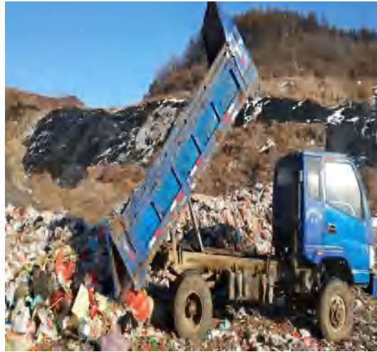
运至清原县垃圾填埋场处理
