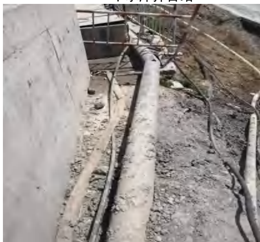
下水库拌合站回水管道
