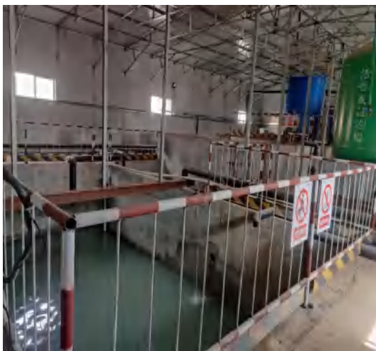
通风洞污水处理设施
