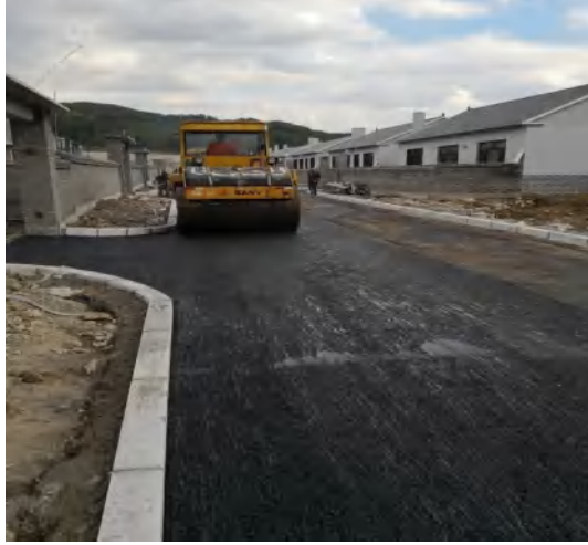
移民安置点道路建设
