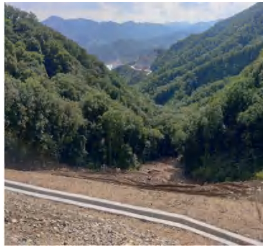
浆砌石排水沟
