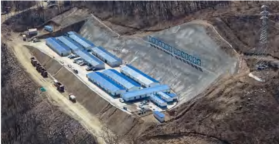
上水库污水处理设施位置
