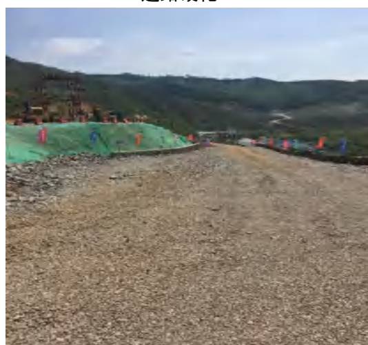
边坡防尘网及道路硬化
