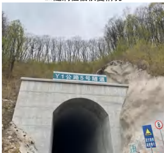
5#隧洞植被恢复情况
