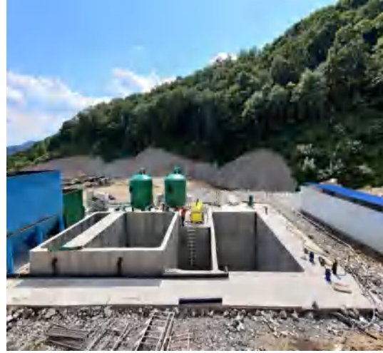
引水中支洞污水处理设施
