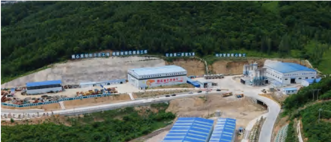
地下工程混凝土生产系统
