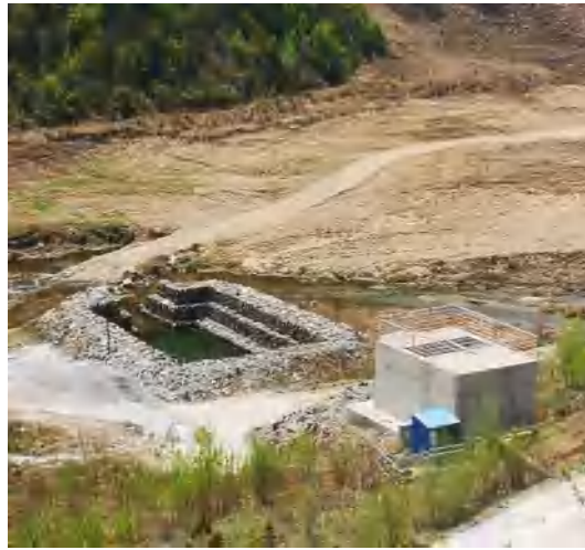
一级泵站实拍图
