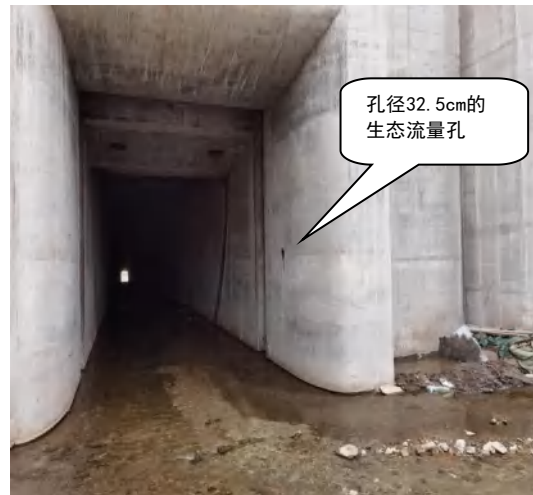
下水库泄洪洞进口
