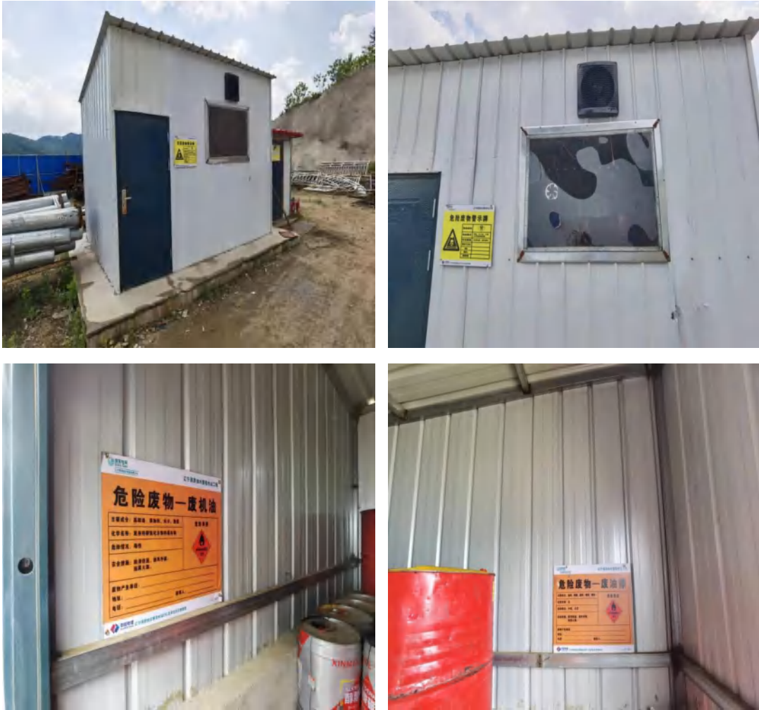
一工区危废暂存间
