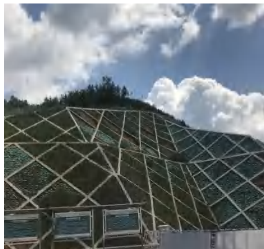
通风洞边坡绿化及防护
