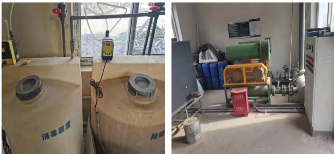
下水库营地污水处理设施
