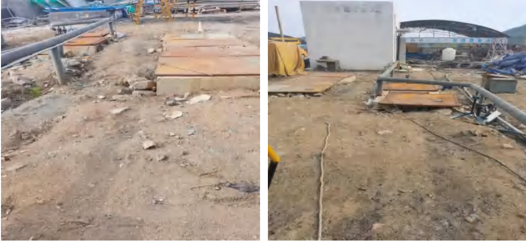
下水库营地污水处理设施
