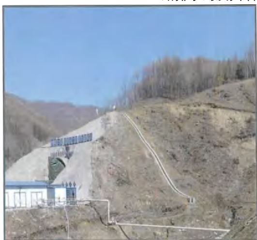
厂房通风兼安全洞边坡排水沟修建情况 (2018. 12) 出线洞洞口边坡防护情况 (2020. 12)
