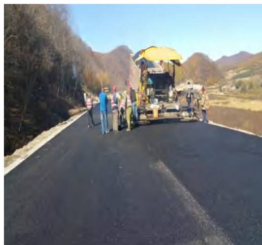
北夏线路面铺筑
