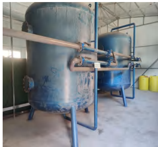
引水上支洞污水处理设施
