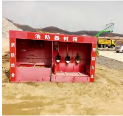
现场消防器材存放区
