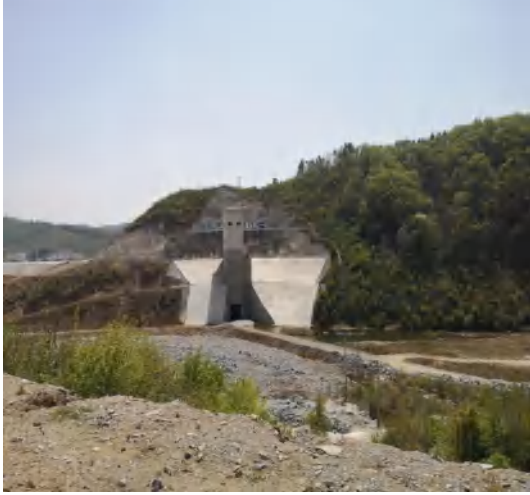
下水库泄洪洞进口
