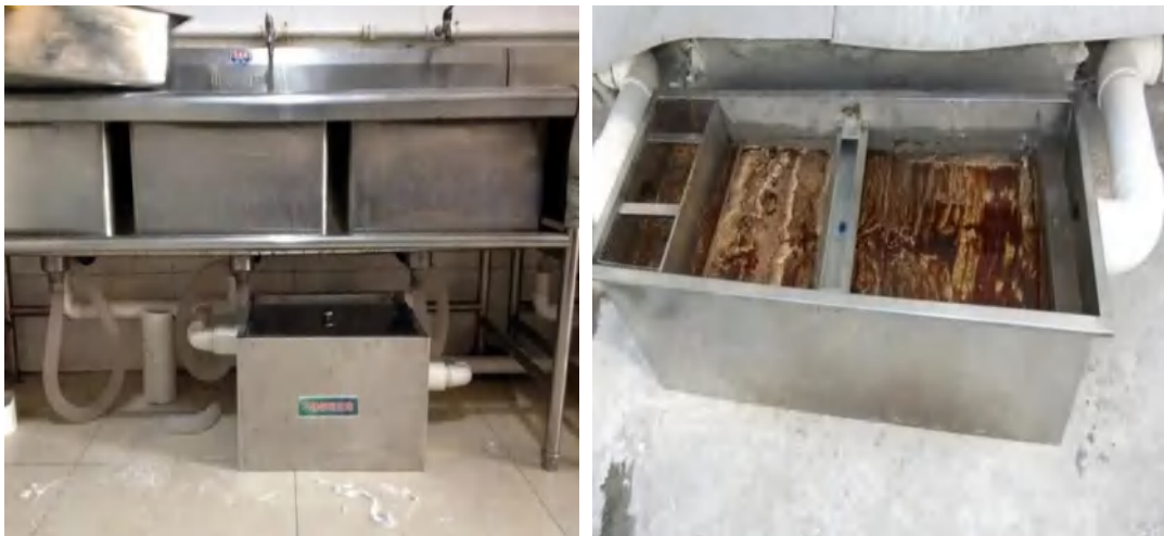
食堂设置餐厨废水隔油池
