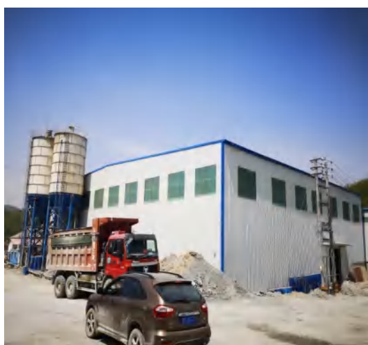
下水库拌合站
