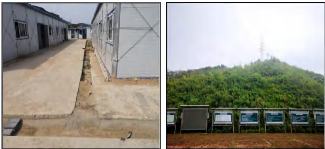
施工生产生活区及边坡防护绿化情况
