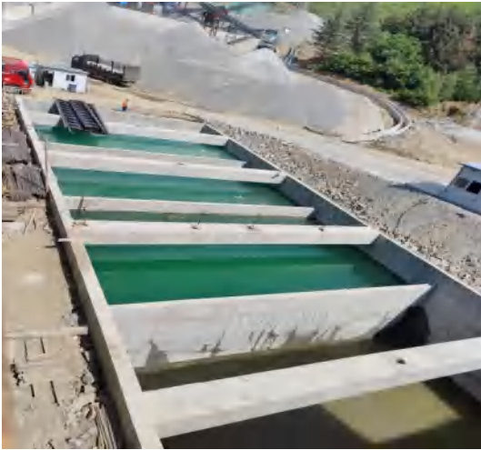
事故池（建设初期蓄水测试）
