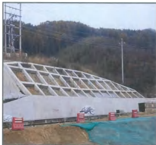
进场交通洞边坡防护及排水沟修建情况 (2019. 9) 进场交通洞边坡防护修建情况 (2019. 10)
