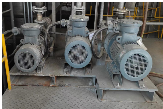
泵类基础减震及软连接
