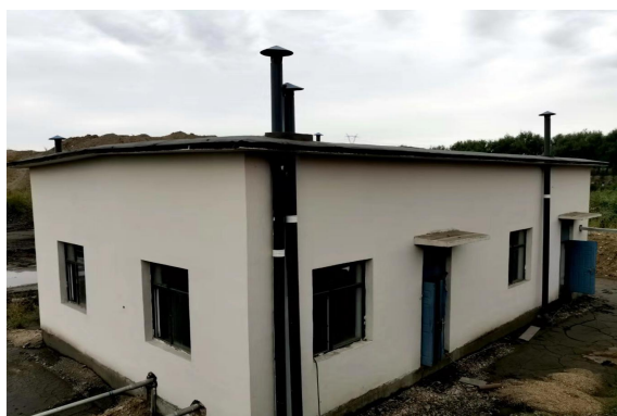
铁岭大伙房污水处理站
