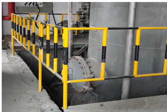
一级防控——储罐围堰
