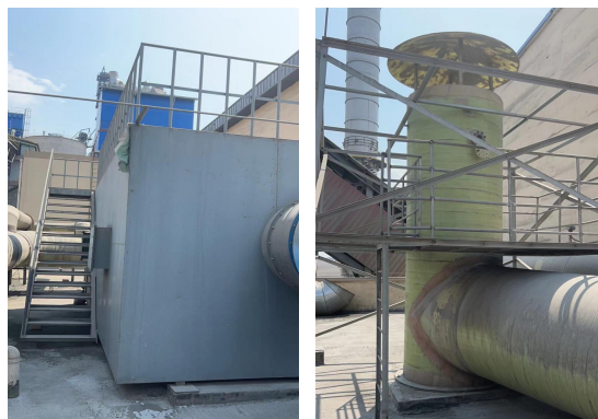
SMP 综合处置厂房活性炭吸附装置及排气筒
