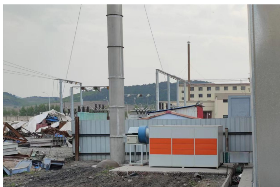
3#危废贮存库活性炭吸附装置
