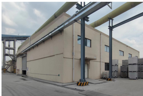
危险废物贮存库
