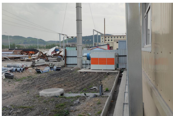
初期雨水池（3#危废贮存库）
