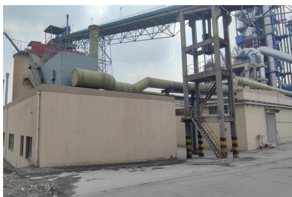
危废贮存库集气系统
