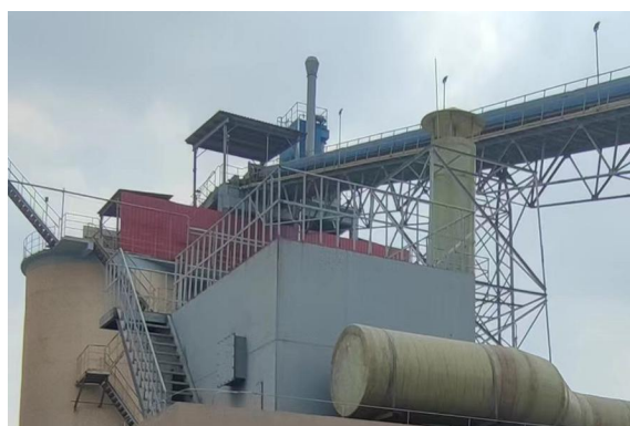
危废贮存库活性炭吸附装置及排气筒
