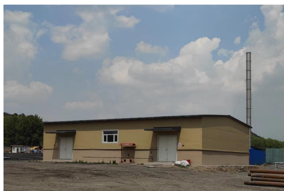
3#危废贮存库排气筒
