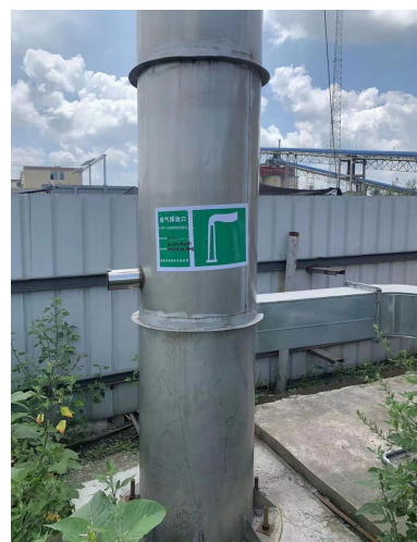
DA003——3#库废气排放口
