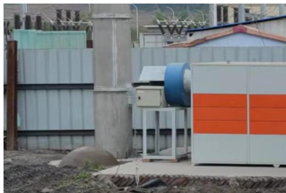
风机基础减震
